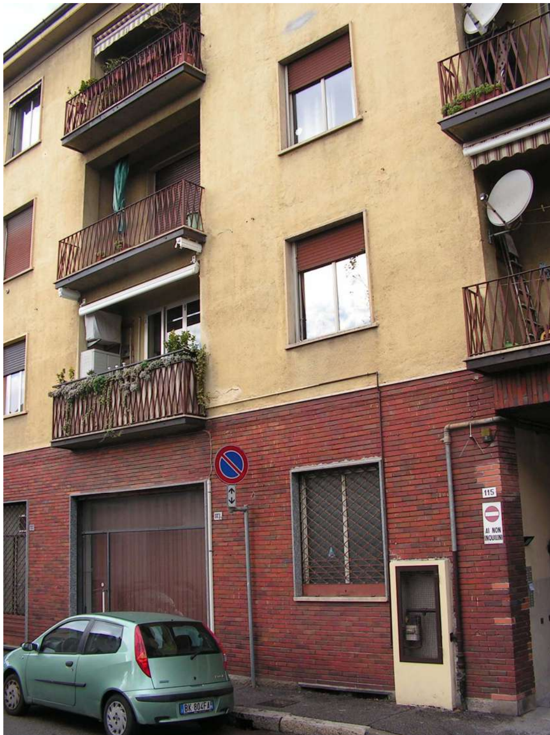
Vista esterna da via XX Settembre.
