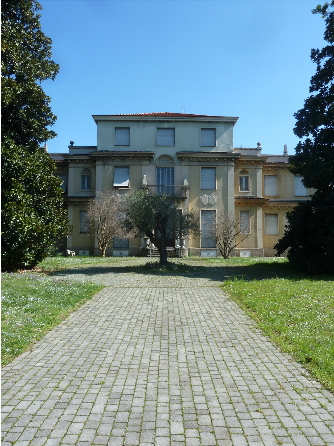
Fig. 7.1: Facciata principale verso l'ingresso a ovest.
