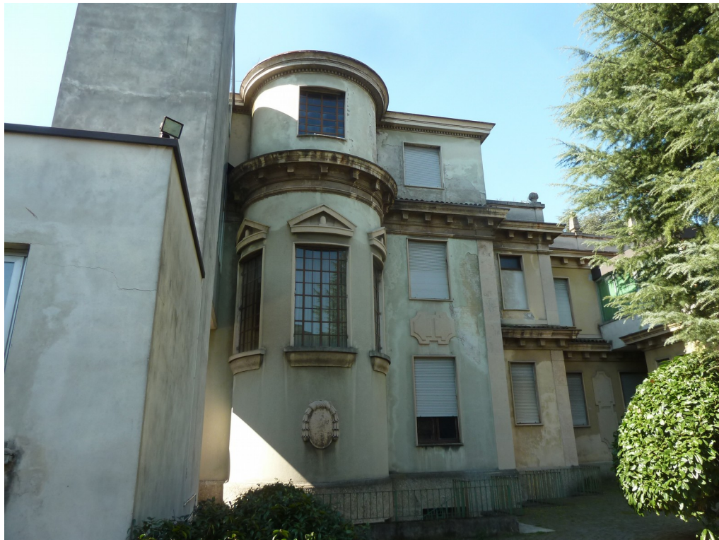
Fig. 7.5: Prospetto posteriore a est e torre ascensore.
