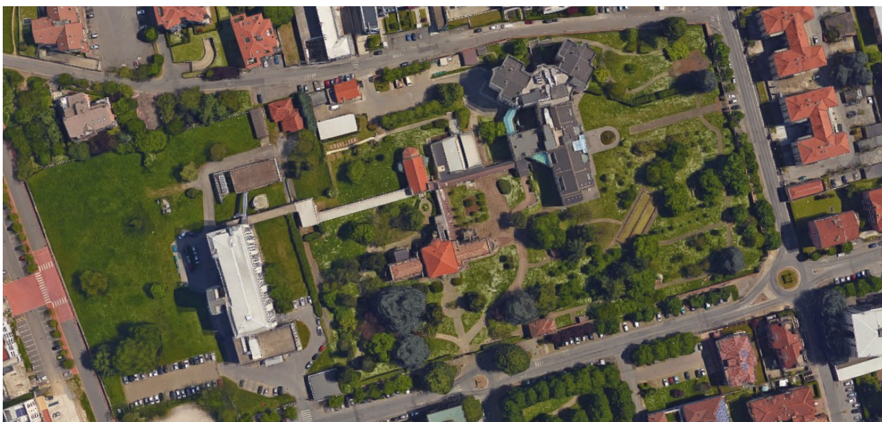
Fig. 1.1: Foto aerea del complesso comprendente ex-ospedale, casa di riposo e nuovo ospedale
