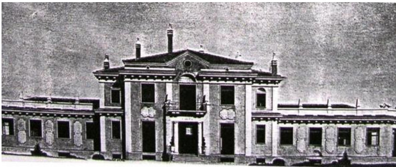
Fig. 3.1: Prospetto verso via Bernasconi negli anni '30 (ing. Giannino Ferrini)
