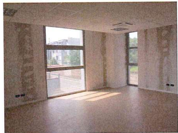
Ufficio al piano 1° - Locale 2
