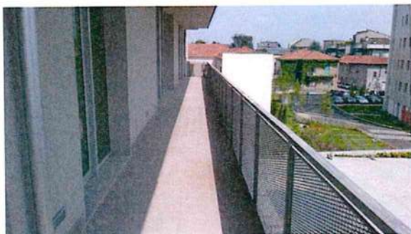
Ufficio al piano 2° - Balcone
