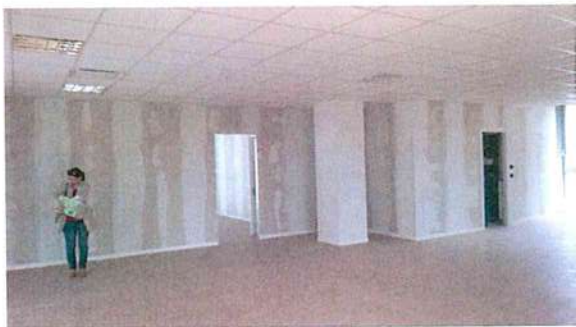
Ufficio al piano 1° - Locale 2
