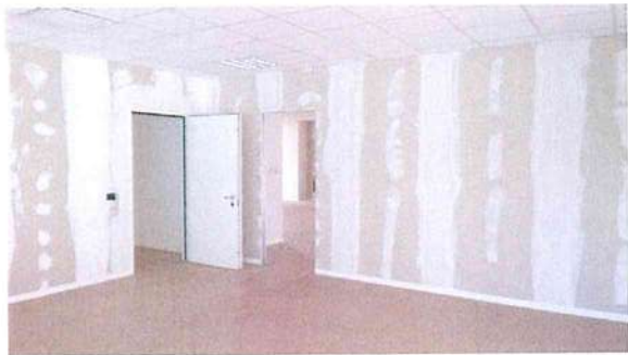
Ufficio al piano 1° - Locale 1
