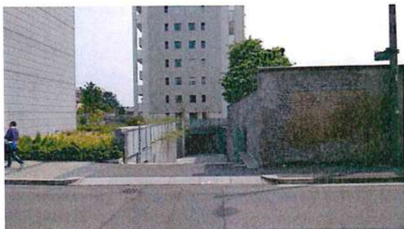
Ingresso carraio al piano interrato
