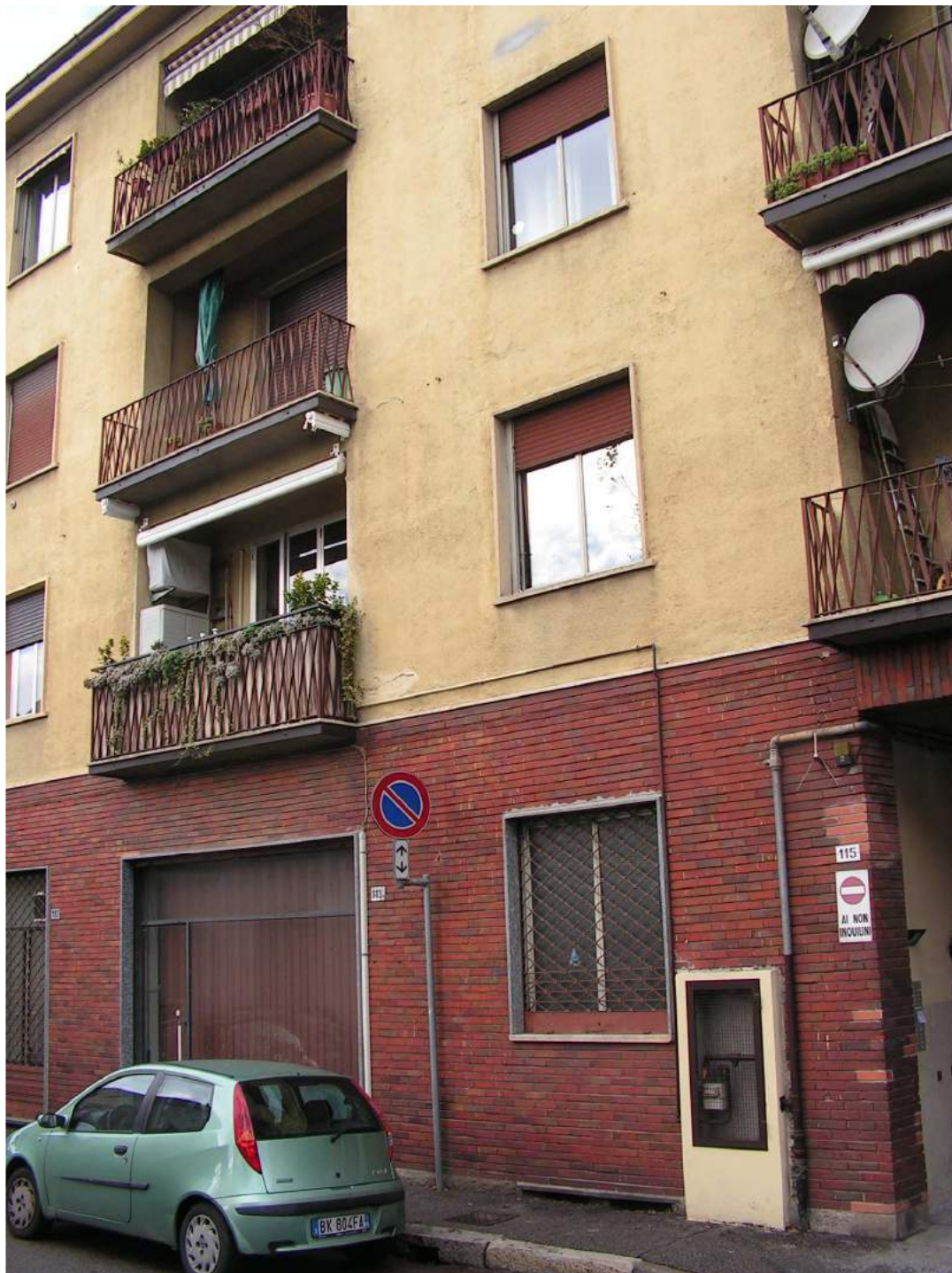
Vista esterna da via XX Settembre.
