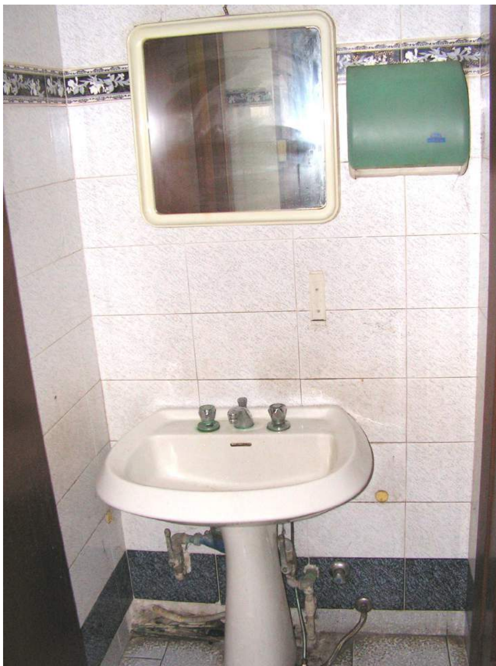
Bagno interno di servizio.
