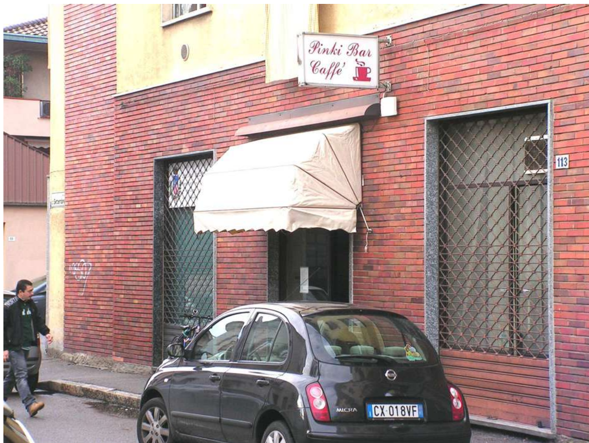
Vista esterna da via XX Settembre.
