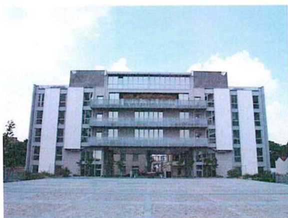
Vista edificio da piazzale interno
