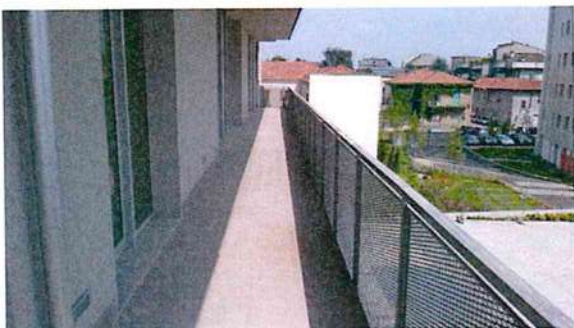
Ufficio al piano 2° - Balcone
