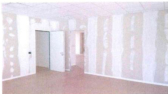
Ufficio al piano 1° - Locale 1
