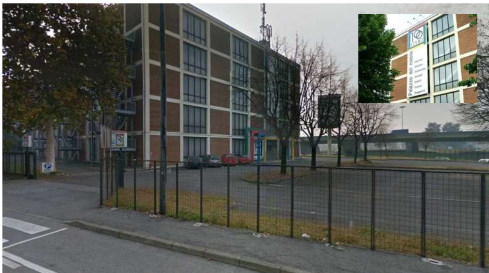
Vista edificio esistente oggetto di riqualificazione
