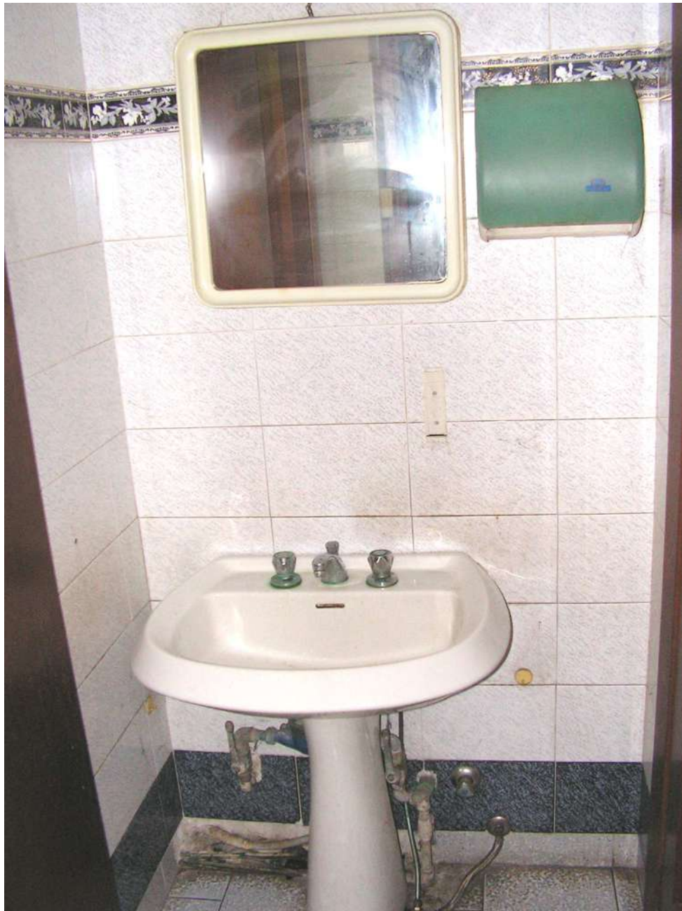
Bagno interno di servizio.
